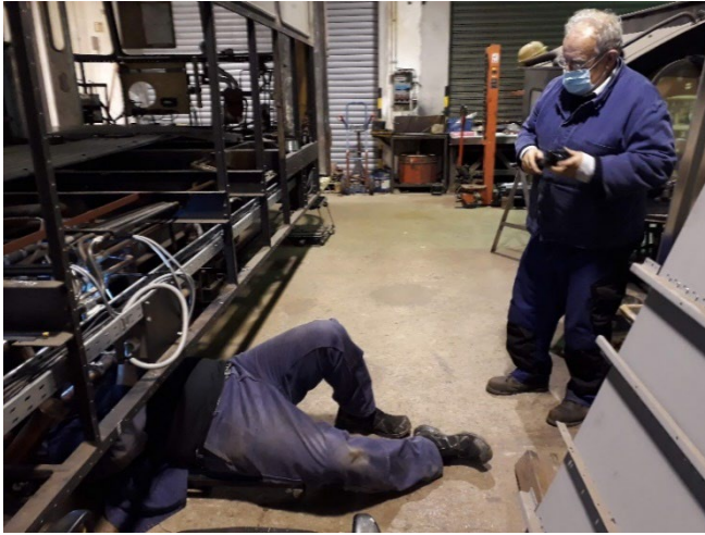
Après la pause imposée par COVID : Renouvellement complet de l'installation électrique. Des goulottes à câbles sont mises en place, les câbles tirés et raccordés aux différents organes et répartiteurs. (novembre 2020)
