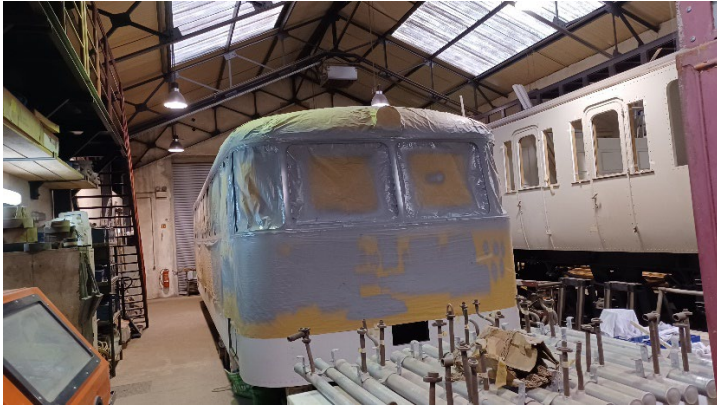
La partie supérieure de la caisse est mise en peinture (août 2022)
