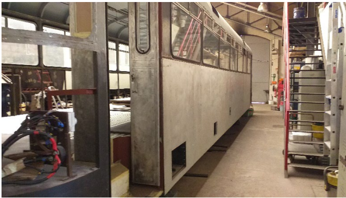
Mise en place et rivetage des nouvelles tôles alu de la jupe (avril 2021)
