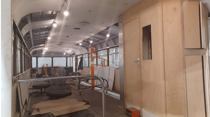
Les fenêtres remises en état ont retrouvé leur place. A l'intérieur l'habillage du pavillon est renouvelé en septembre 2023
