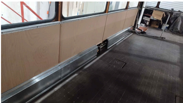
A l'intérieur la partie sous la bande des fenêtres a été rénovée et remise en place (janvier 2024)
